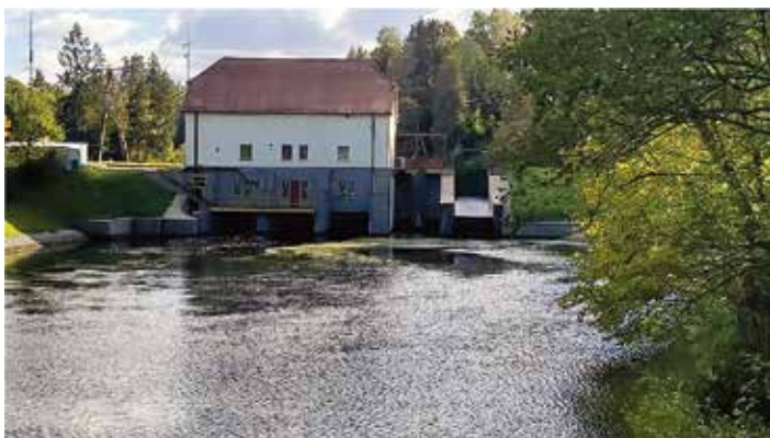
Elektrownia wodna „Łyna”, foto: Paweł Szemiota
